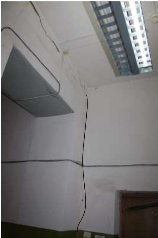
Фото №24. Вертикальная трещина между стен в осях «10/Б» с отметки +3.580 до отметки +7.170м.
