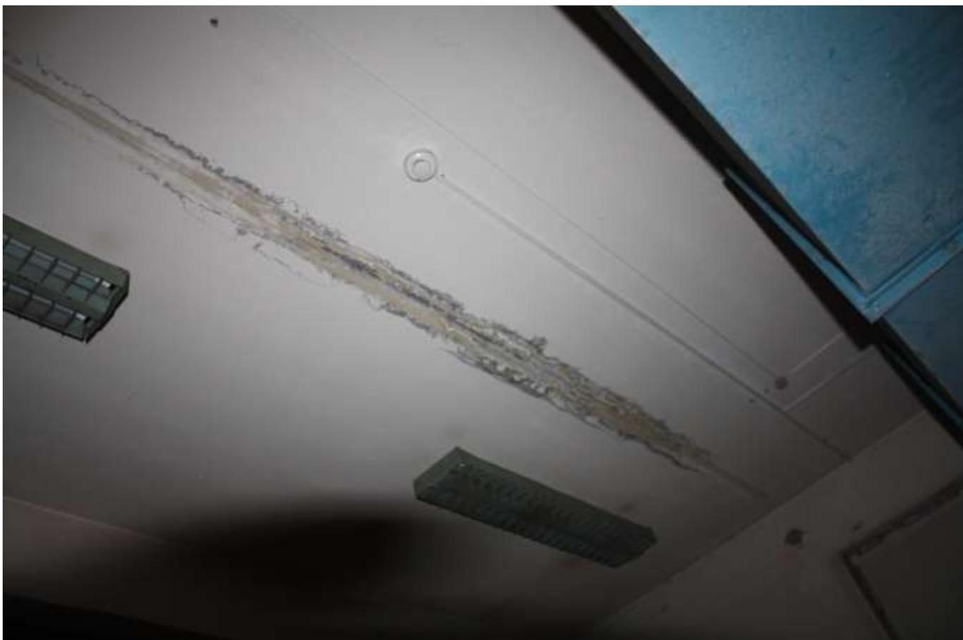
Фото №16. Разрушение бетона замоноличивания в стыках пустотных плит перекрытия в осях «1-2/В-Г» на отметке +3.440м.
