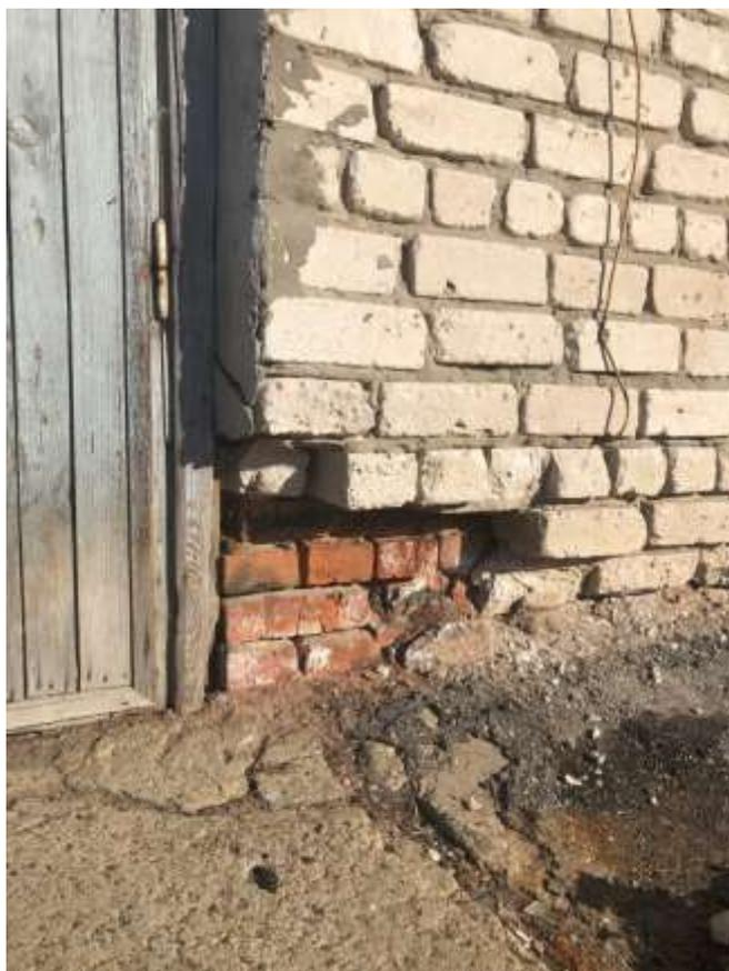
Фото №36. Разрушение кирпичной кладки у дверного проема с внешней стороны стены в осях «8-9/А» на отметке 0.000м. Разрушение отмостки площадью 2м<sup>2</sup>.
