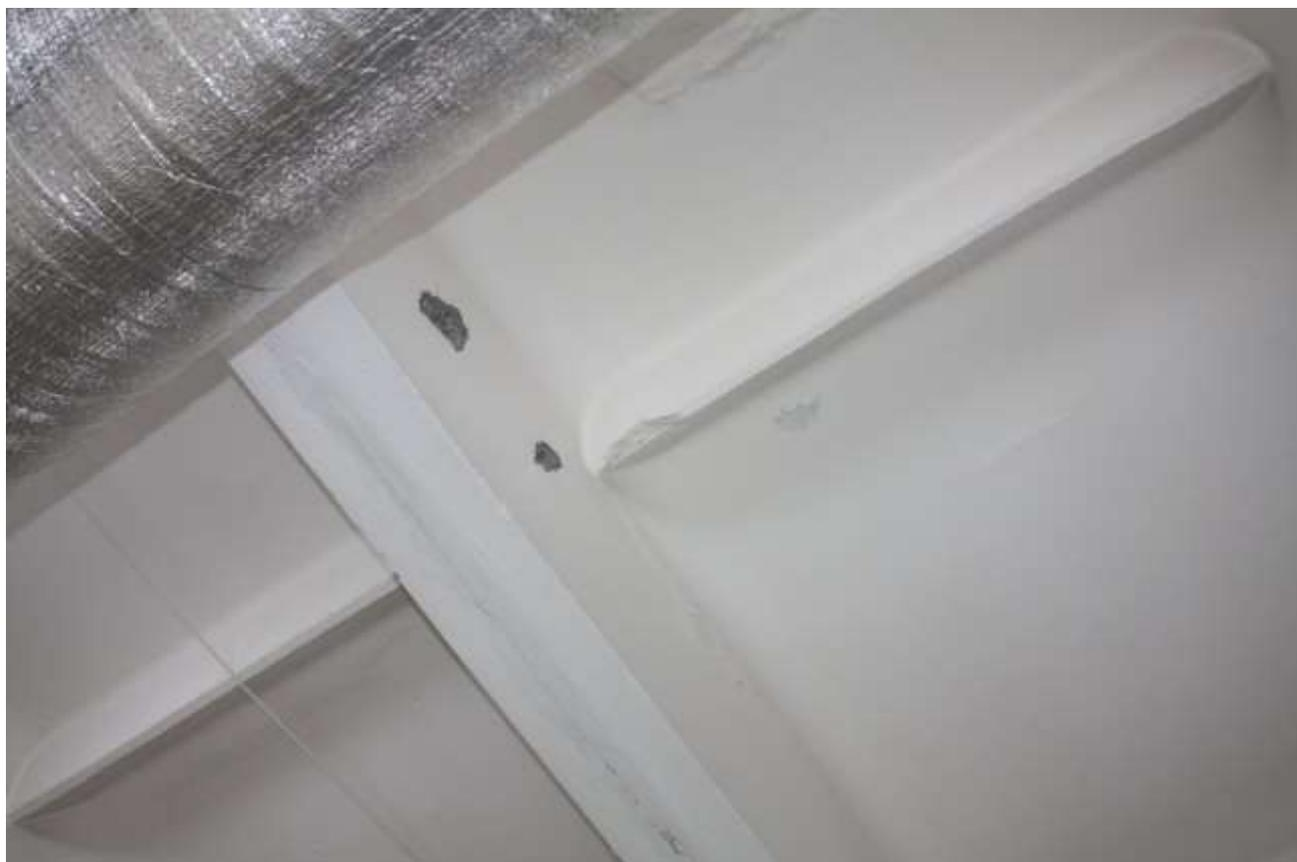
Фото №4. Разрушение защитного слоя бетона и оголение арматуры поперечного ребра 6-ой ребристой плиты покрытия от оси «7» на отметке +11.180м.
