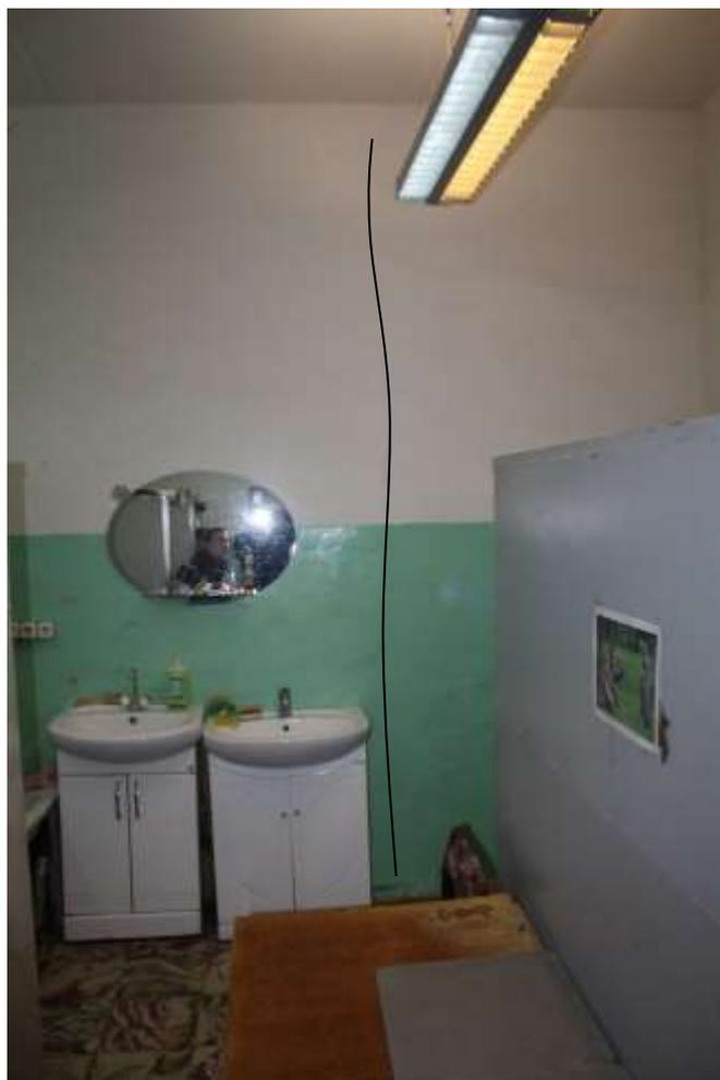
Фото №20. Вертикальная трещина в стене по оси «9-10/В» с отметки 3,580м до отметки +7.100м.
