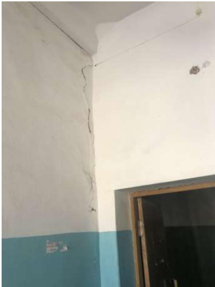
Фото №30. Вертикальная трещина между стен в осях «9/В» с отметки +7.170м до отметки +11,180м.
