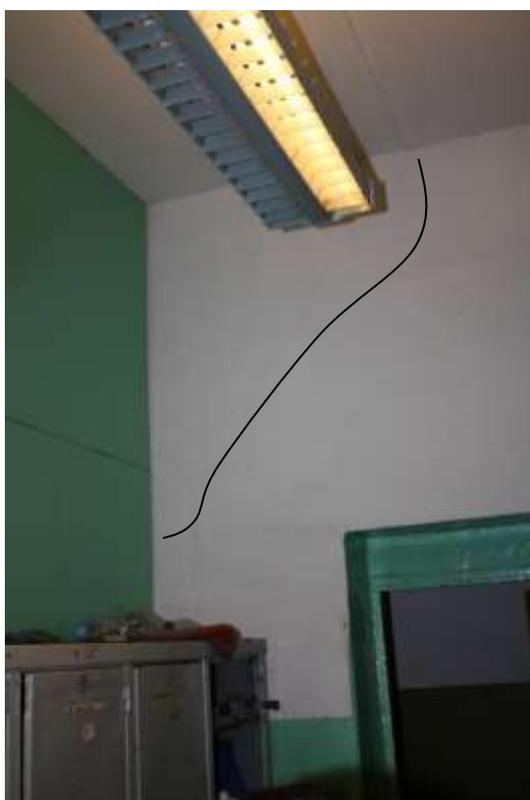
Фото №21. Наклонная трещина в стене в осях «9/Б» на отметке +4.600м.
