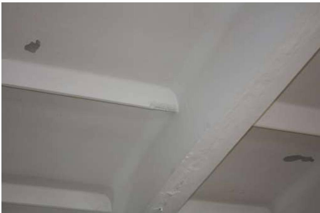
Фото №3. Разрушение защитного слоя бетона и оголение арматуры поперечного ребра 2-ой ребристой плиты покрытия от оси «6» на отметке +11.180м.
