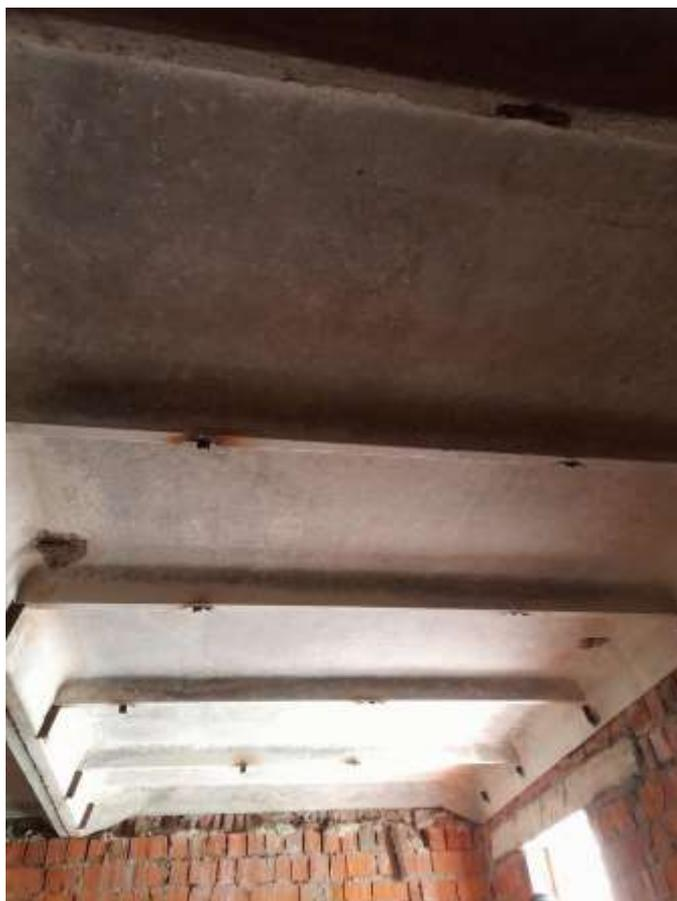
Фото №10. Разрушения защитного слоя бетона поперечных ребер 1-ой ребристой плиты покрытия от оси «8» в осях "7-8/Б-В" на отметке +13.530м.
