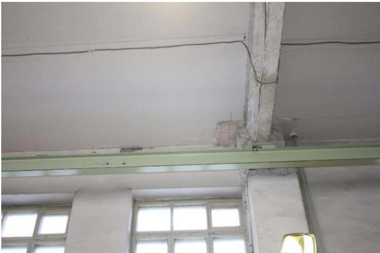
Фото №25. Трещина в 1-ой от оси «Г» пустотной плите перекрытия в осях 6/Г на отметке 6.970м.
