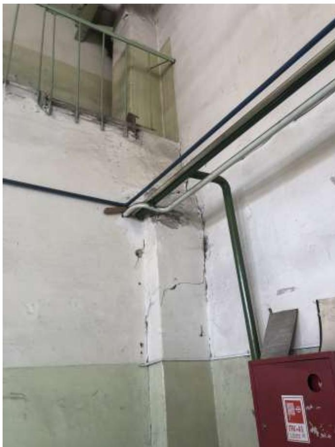
Фото №14. Вертикальная трещина между колонной площадки и наружной стеной в осях «В/2» на отметке +2.500м.
