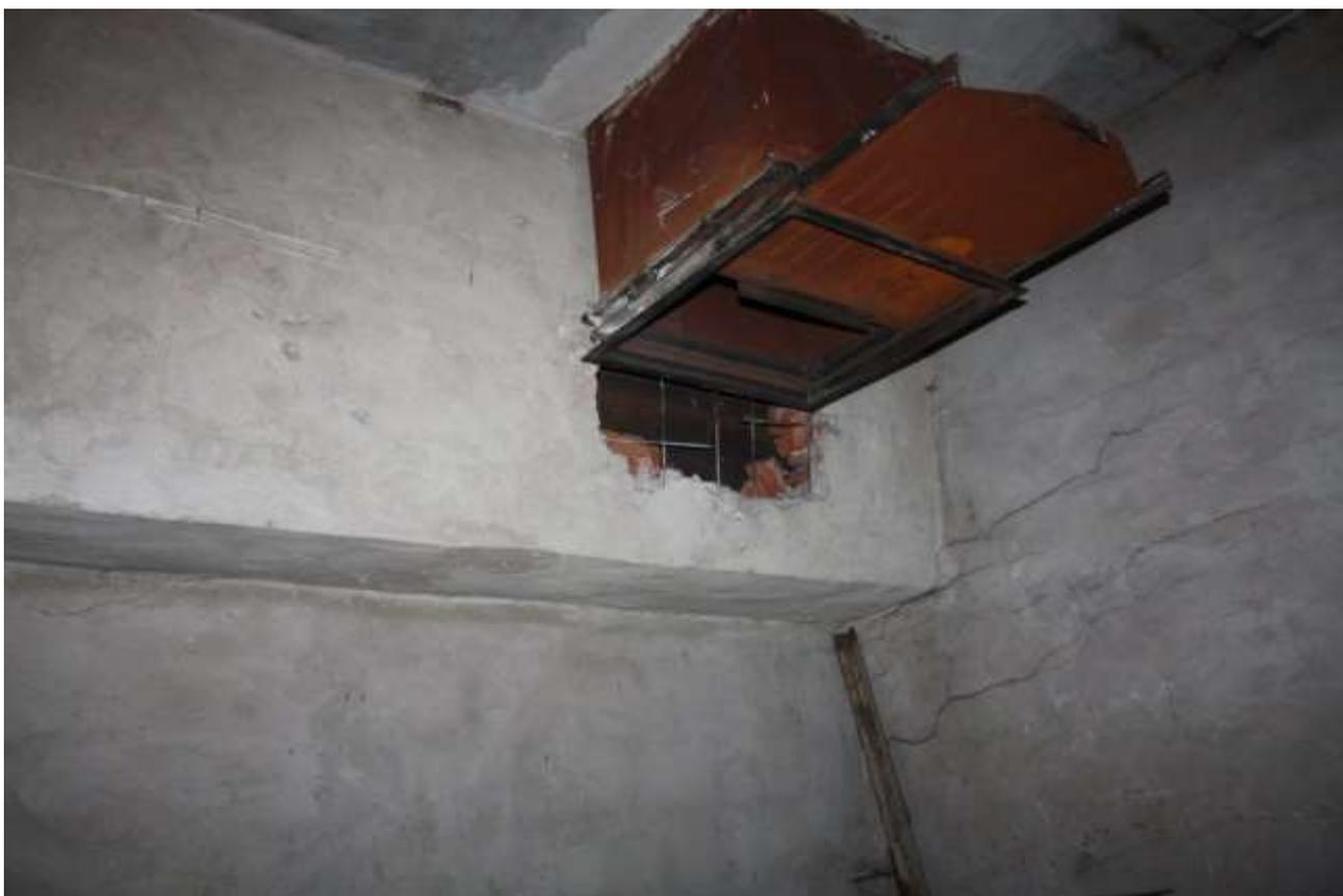
Фото №8. Поверхностная коррозия металлической балки в осях «1/Б-Г».
