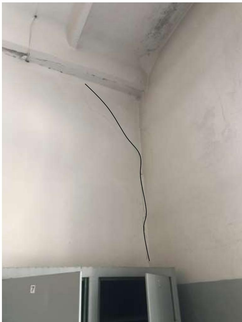
Фото №28. Вертикальная трещина между стен в осях «8/Г» с отметки +7.170м до отметки +11,180м.
