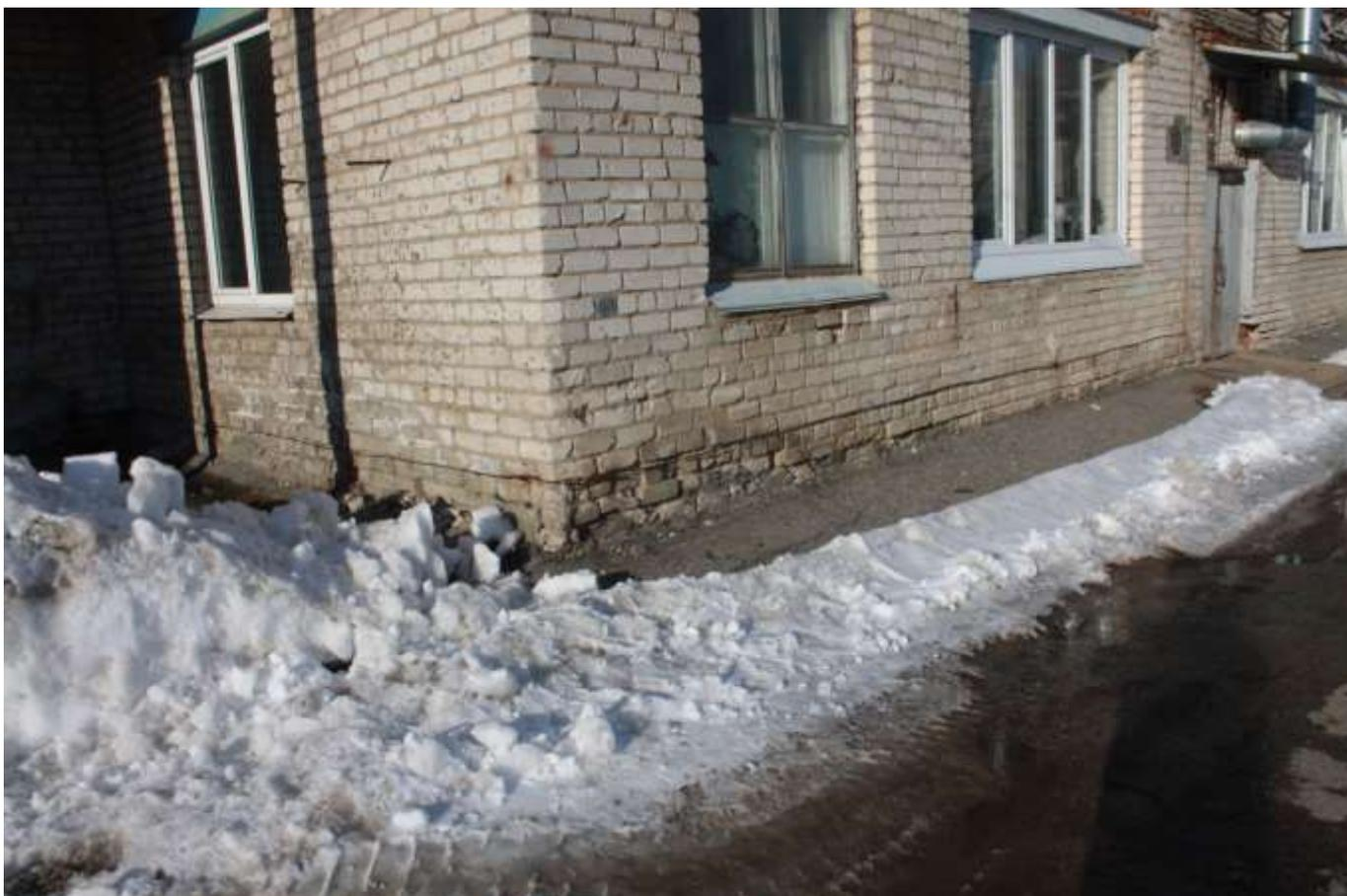
Фото №38. Разрушение кирпичной кладки с внешней стороны стены в осях «7-8/А» на отметке 0.000м.
