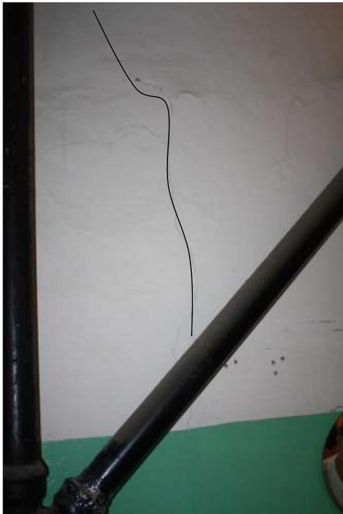
Фото №22. Наклонная трещина в стене осях «8-9/В» на отметке +4.560м.
