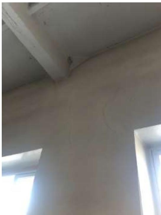
Фото №29. Трещины в стене над простенком в осях «8-9/Г» на отметке +6.700м.
