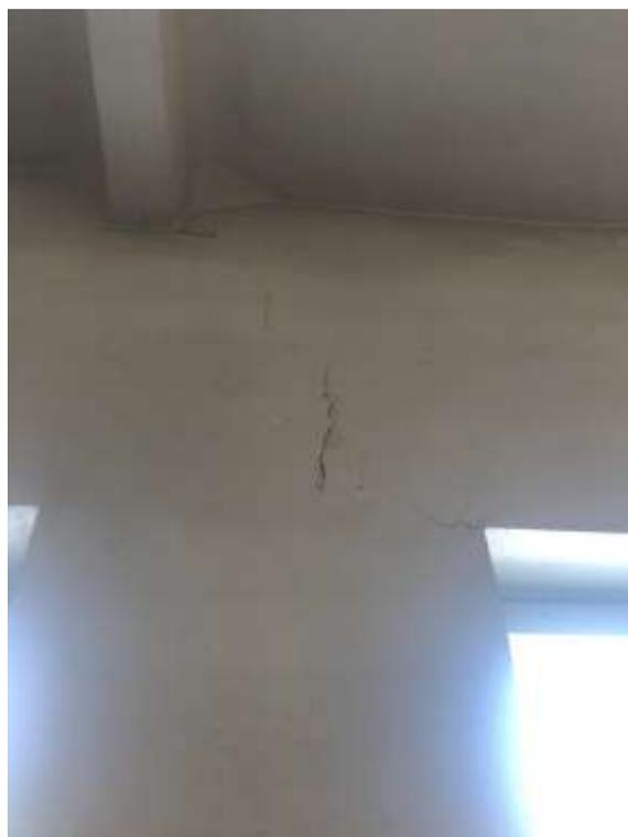
Фото №31. Трещина в стене над простенком в осях «9-10/Г» на отметке +11.170м.
