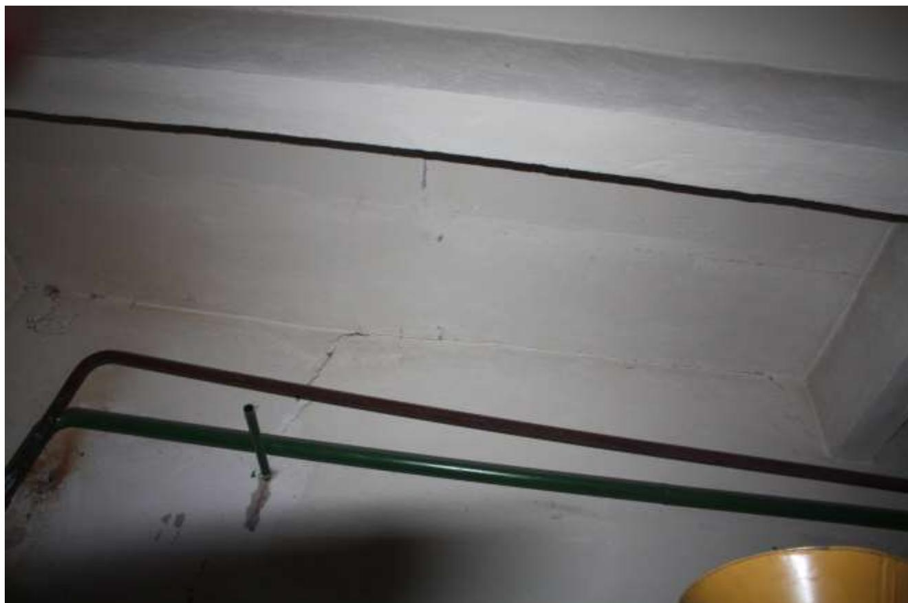
Фото №15. Вертикальная трещина в стене по оси «1» на отметке +3.140м.
