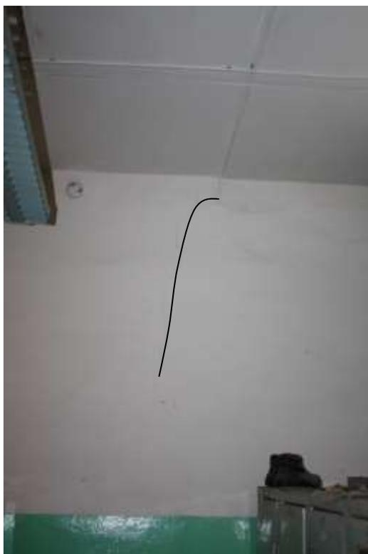
Фото №23. Вертикальная трещина в стене осях «8-9/Б» на отметке +4.600м.
