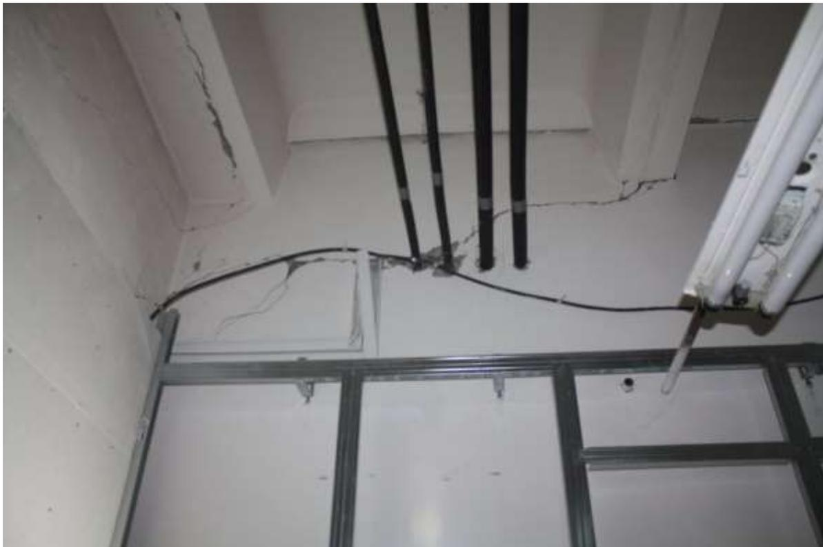
Фото №1. Сквозные трещины кирпичной стены раскрытием более 3мм по оси «1» с отметки +7.170м до отметки +11.180м.
