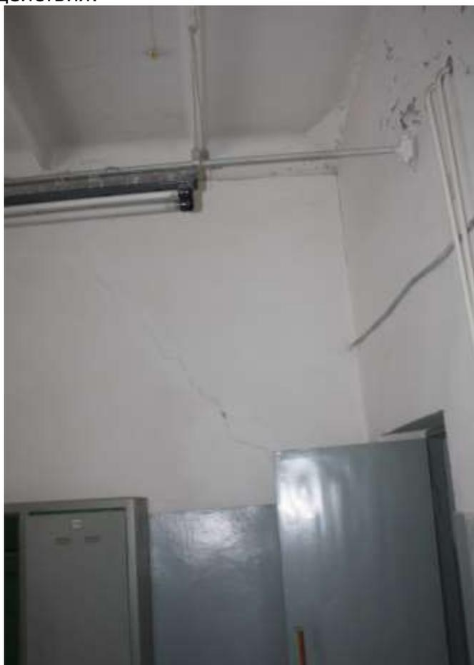
Фото №13. Трещина стены по осям «Г-В/10» с отметки +7.410м до отметки +11.200м.
