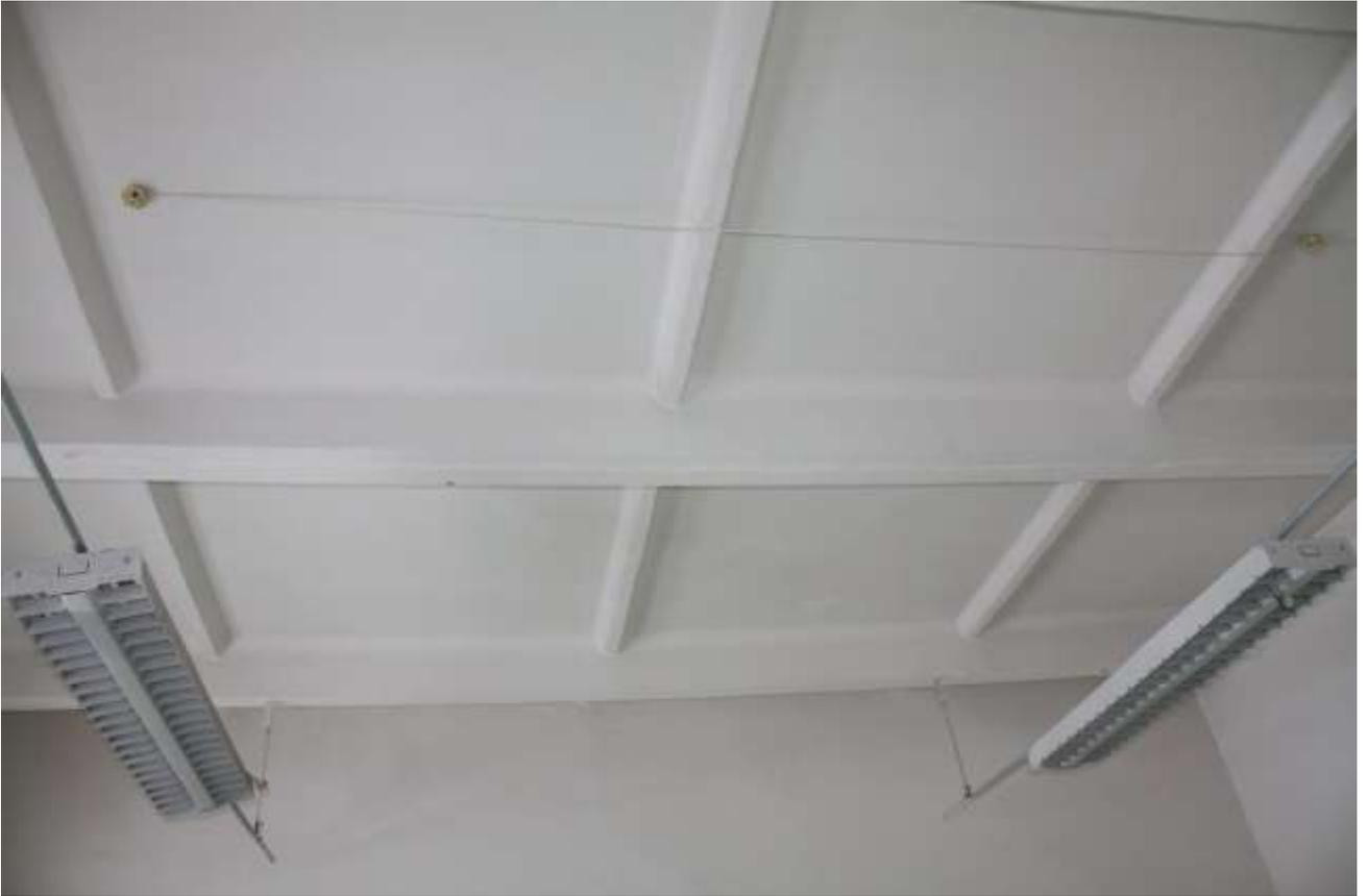
Фото №5. Прогиб ребристых с вертикальными трещинами плит покрытия в осях «7-10/A-B» на отметке +11.180м.
