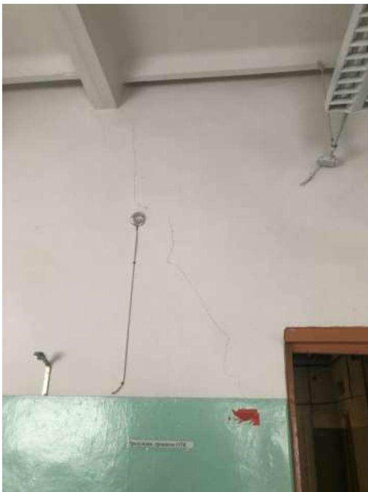
Фото №32. Трещина в стене над простенком в осях «9/Б» с отметки +9.100 до отметки +11.170м.
