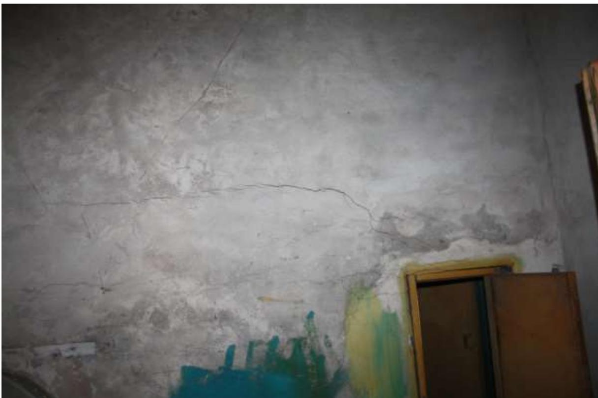
Фото №18. Горизонтальная трещина в перегородке в осях «1-2/В-Г» на отметке +2.000м.
