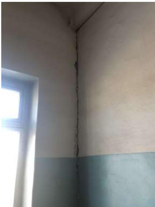
Фото №33. Вертикальная трещина между стен в осях «10/Г» с отметки +7.170м до отметки +11,180м.
