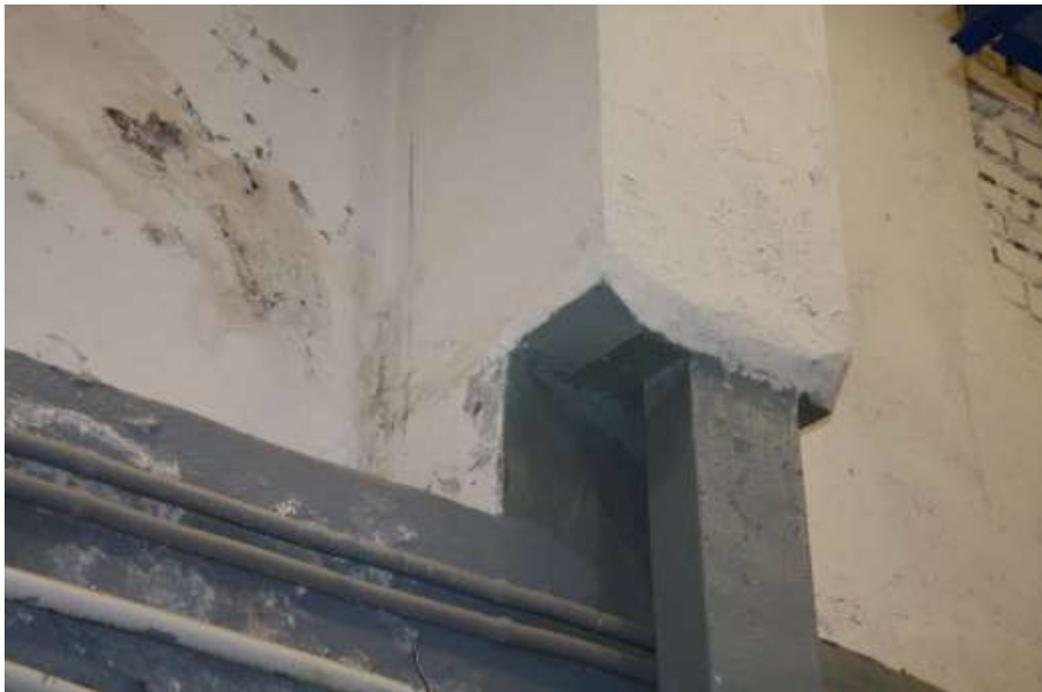
Фото №40. Трещина на пилястре в подвале на отметке 0,000м в осях 9/В.
