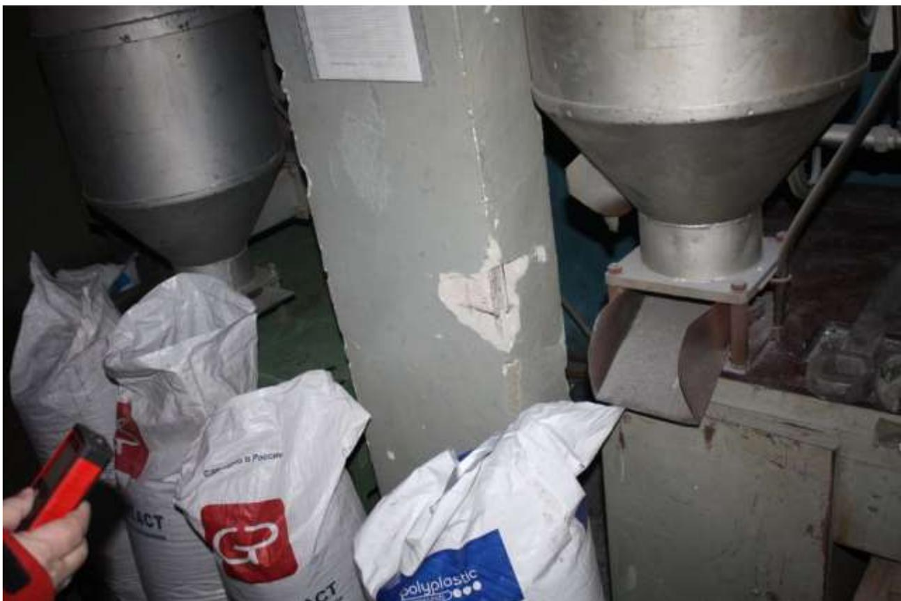
Фото №7. Разрушение противопожарной защиты металлической колонны из двутавра в осях «1/В».
