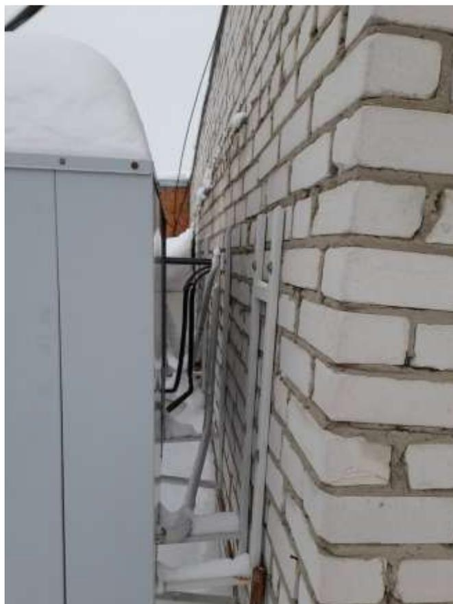
Фото №12. Смещение участка кирпичной стены по оси «1» на отметке +10.820м в результате силового воздействия.
