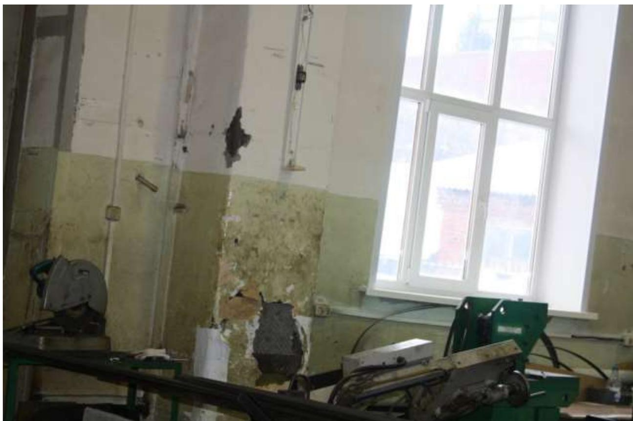
Фото №9. Разрушение штукатурного слоя пилястры кирпичной стены по оси «5/Б».
