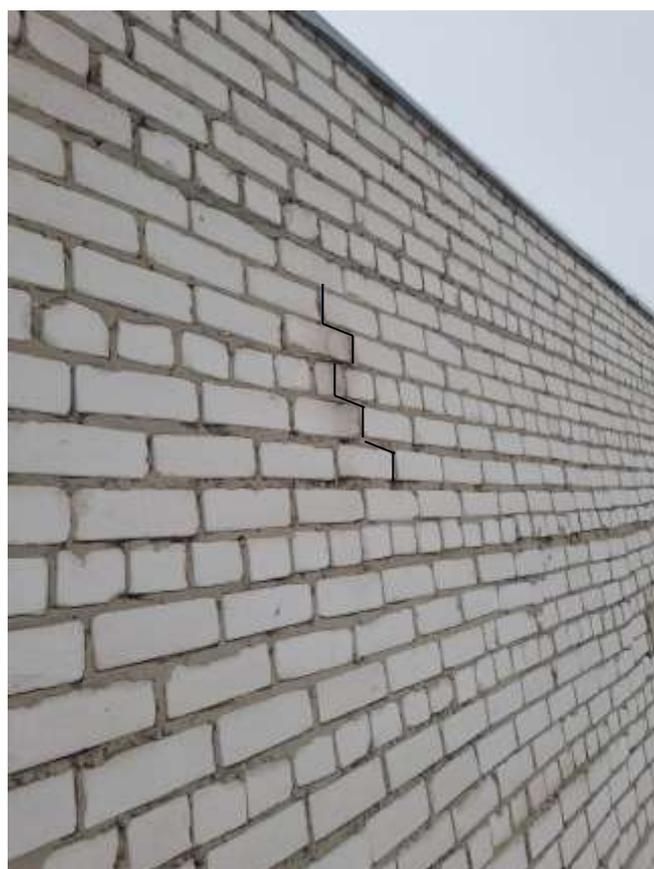
Фото №11. Трещина с наружной стороны кирпичной стены по осям «Б/1» с отметки +10.820м до отметки +11.800м.
