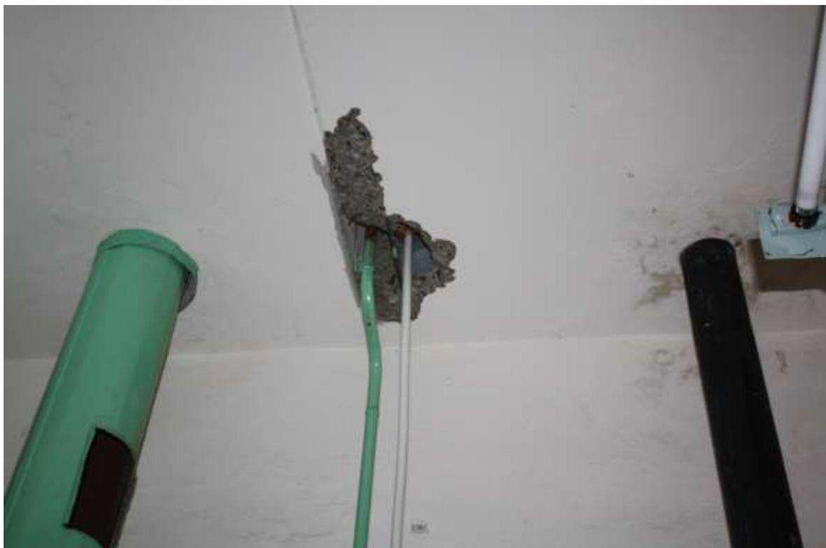
Фото №27. Разрушение защитного слоя бетона пустотной плиты перекрытия в осях «8-9/В» на отметке +7.170м.
