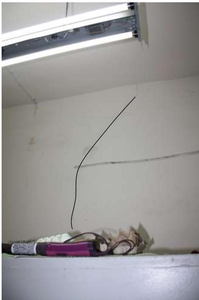
Фото №19. Наклонная трещина в стене в осях «10/Б-В» на отметке +4.500м.
