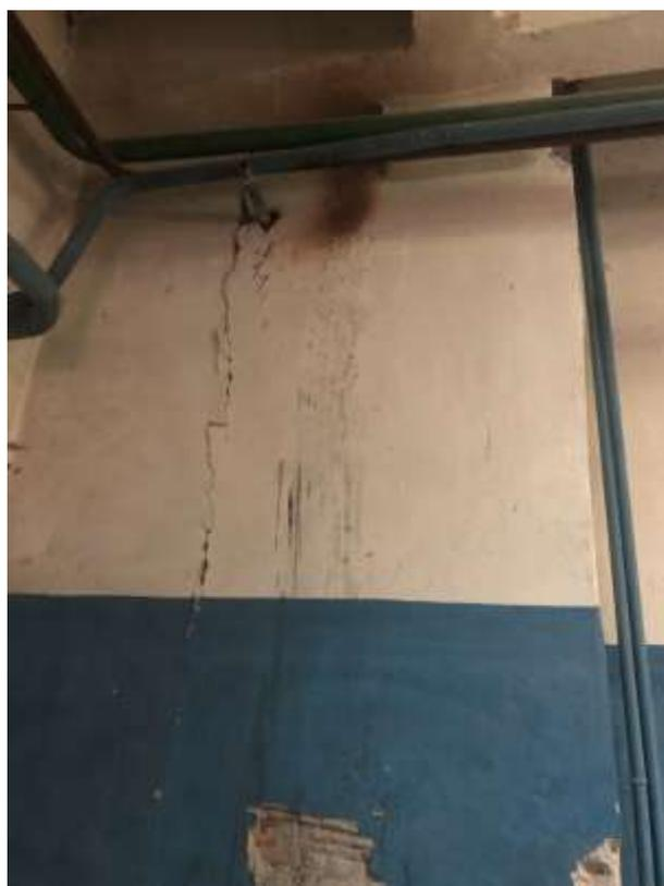
Фото №17. Вертикальная трещина в стене по оси «1/Г» с отметки 0,000м до отметки +3.400м.
