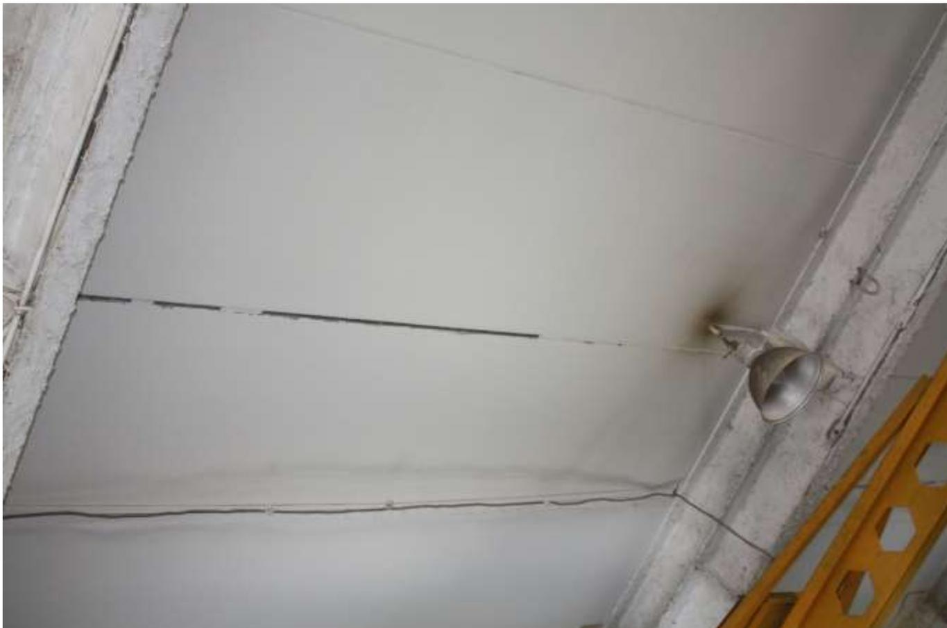
Фото №26. Разрушение бетона замоноличивания в стыках пустотных плит перекрытия в осях «6-7/В-Г» на отметке +6.950м.
