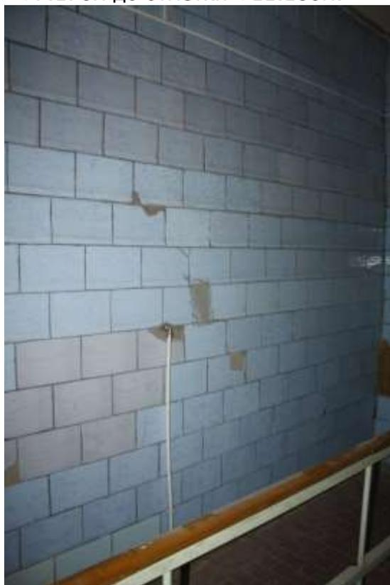
Фото №2. Сквозные трещины кирпичной стены раскрытием более 3мм по оси «1» с отметки +7.170м до отметки +11.180м.
